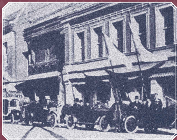
明治24年、横浜の中心街・本町1丁目13番地に新築された明治屋の社屋。
